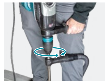
Za siguran rad obavezno držite crevo usisivača rukom ili ga naslonite na nogu da sprečite uvrtnje.
