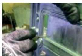
Za brušenje šava za zavarivanje između čeličnih ploča
